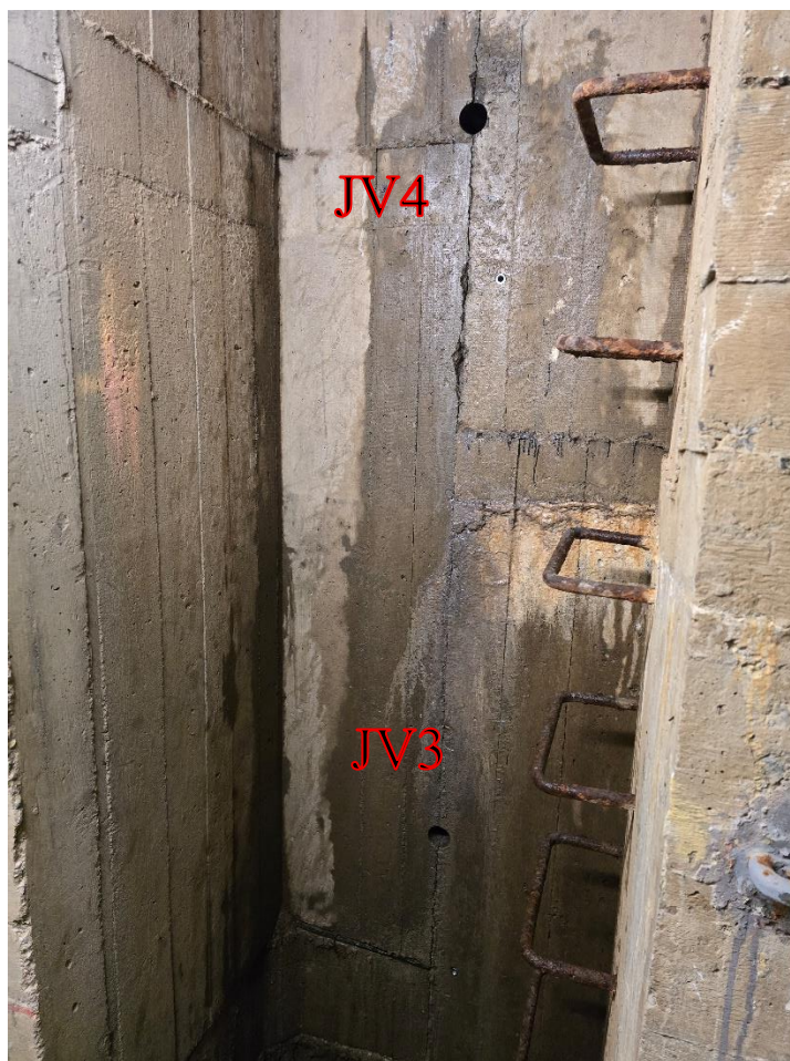
Obr. 4: Poloha jádrových vrtů – hrázová chodba č. 3
